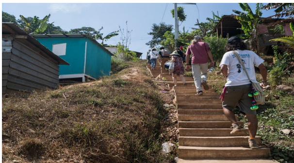
Perú Proyecto comunitario de construcción de caminos
